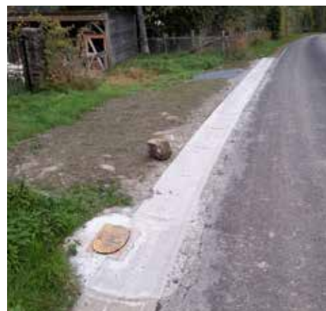
Pose de caniveaux
